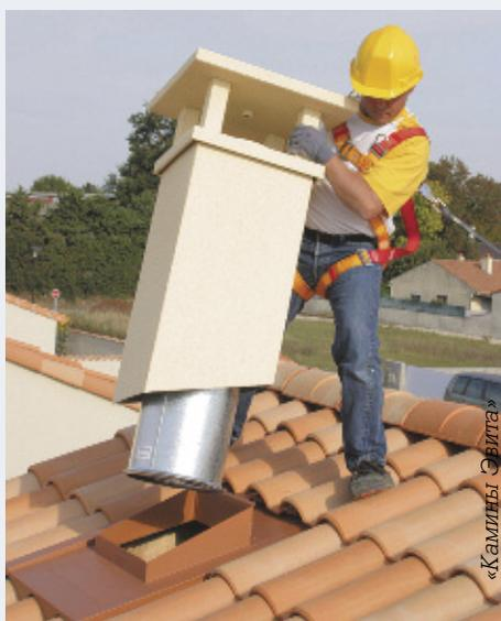
4. Просверлить в коробе отверстия под болты (8,5 мм), а в в верхней плоскости трубы отверстия под анкеры (диаметром 10 мм и глубиной 30 мм). Установить анкеры в подготовленные отверстия.
