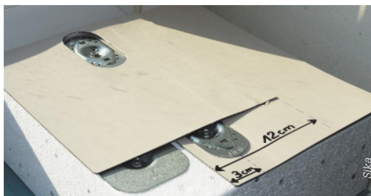
которая сверху заваривается с обеих сторон узкой полосой мембраны (шириной 200 мм), которая образует «кармашек». При таком способе фиксации крепежные элементы можно размещать реже (расстояние между рейками определяется компьютерным расчетом и может достигать 4–5 м).
