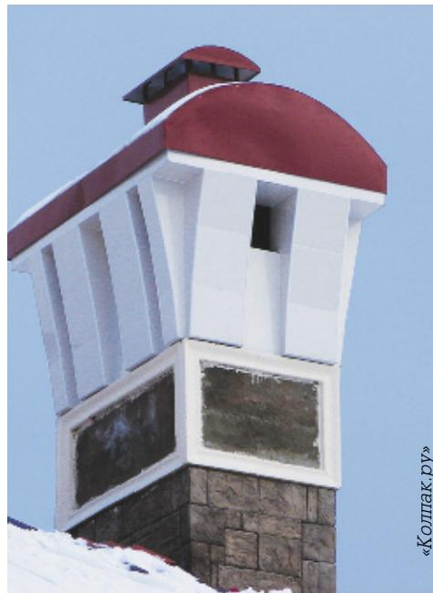
для дополнительного отвода воды. «Юбка» важна как основа флюгарки, которая крепится к трубе. От нее зависит, насколько крепко, прочно и надежно она будет держаться за место крепления. Посредством ножек (бывают простыми или усиленными) к «юбке» крепится крышка флюгарки. Крышка, в зависимости от трубы, делается со вторым дном или без него.
