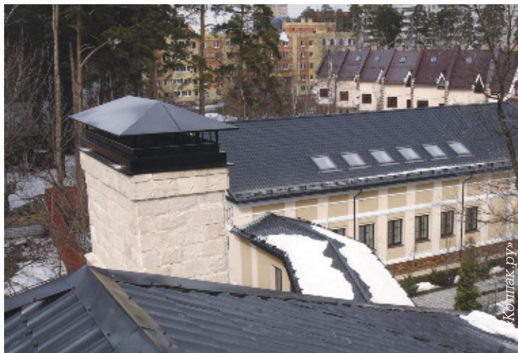
4. Обеспечение интенсивного воздухообмена. Дымники могут также выполнять функции дефлекторов, улучшая тягу из каминной или печной трубы и увеличивая интенсивность воздухообмена при использовании на вентиляционных выходах.
