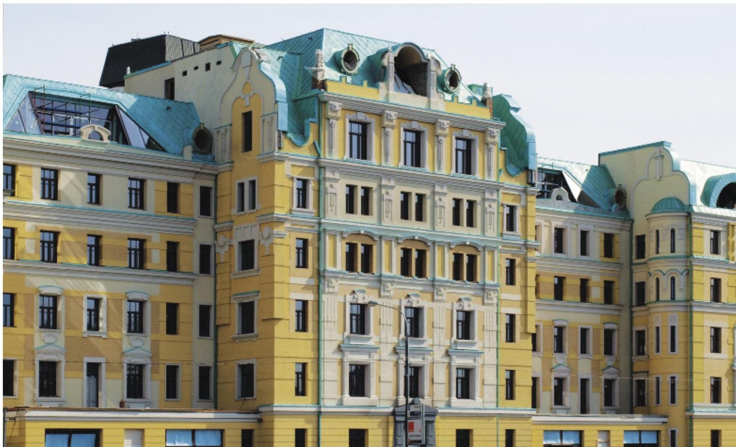
Вся вода с горизонтальных и фигурных парапетов неизбежно будет попадать на фасад, так как защита из патинированной меди выполнена безграмотно: без минимального отступа от стен и вертикальных капельников
