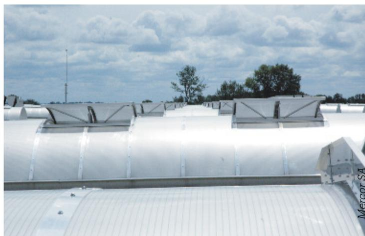
комплексах, на производственных объектах, а также для удаления дыма из этих зданий после пожара (СНиП 41–01–2003, СНиП 31–03–2001 «Производственные здания», СНиП 31–04–2001 «Складские здания», МДС 21–1.98 «Предотвращение распространения пожара»).
