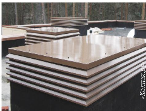
7. Дымоход с крышкой плавной закругленной геометрии
