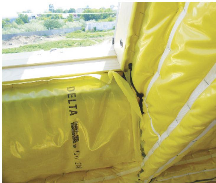
Рис. 8. Ошибки при устройстве пароизоляции окна, негерметичное примыкание пленки к коробке
