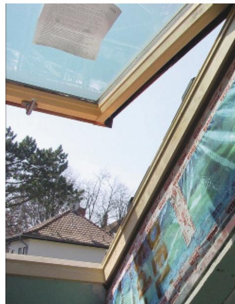
Рис. 10. Дополнительная проклейка углов проемов мансардных окон
