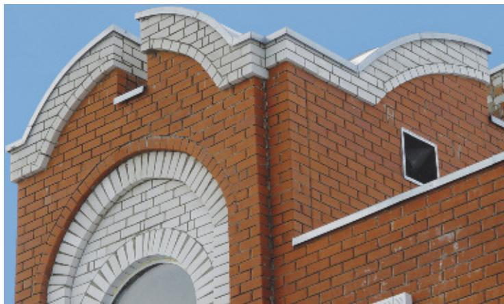
*Вдоль вертикальных бортиков защиты арочных парапетов (выполнена лет 7–8 назад компанией «Саврос») вода уходит до горизонтальной защиты, выполненной с минимальным уклоном в сторону кровли. Вертикальная отбортовка горизонтальной защиты отнесена от стен на 50 мм. Этого достаточно, чтобы система работала безотказно и была долговечной*
