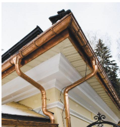
придает материалу эстетичный внешний вид и улучшает его коррозионную устойчивость, а сталь обеспечивает легкость и прочность. Удельный вес листовой меди – 5,4 кг/м<sup>2</sup>, для «Реннер-плюс» этот параметр равен 4 кг/м<sup>2</sup> Кроме того, при изготовлении из меди
