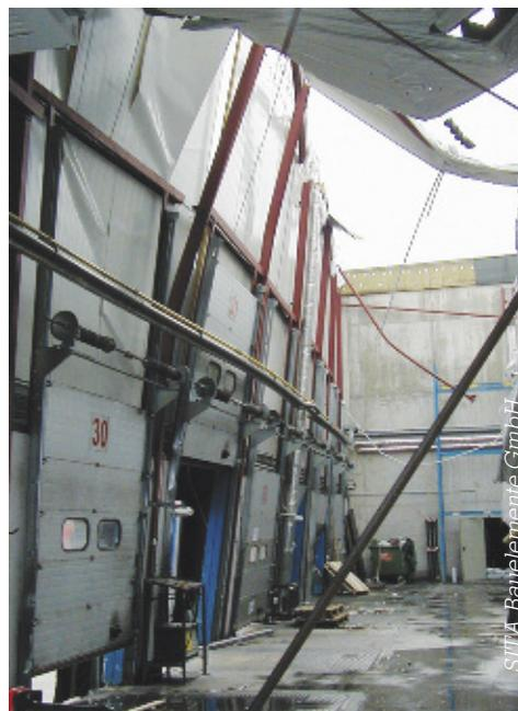
*Германия: крыша этого общественного объекта обрушилась, как доказали эксперты, в результате скопления большого количества воды, вызванного ошибками проектирования внутреннего водостока*
