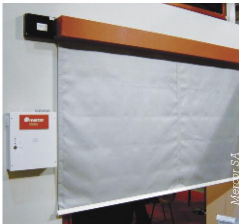
Дымовые занавесы изготавливаются из негорючего материала, ограничивающего проникновение дыма. Стационарные дымовые занавесы могут быть сделаны из стекла, гипсокартонных плит, листового металла, ткани и других материалов.
