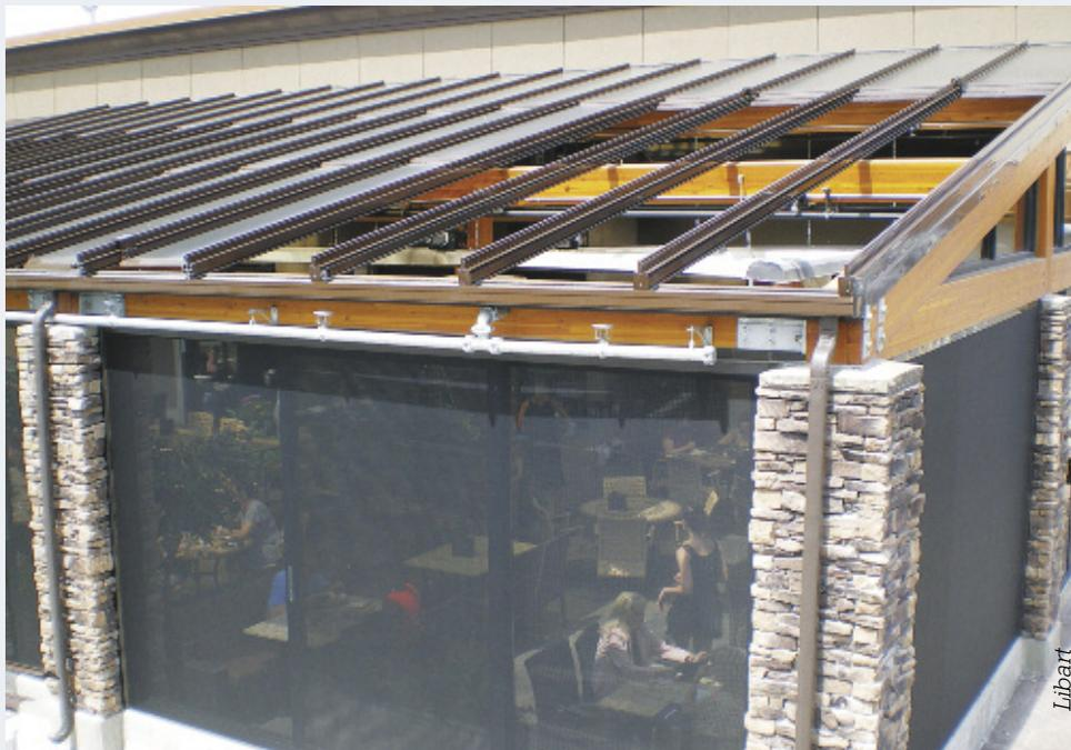
*Пример раздвижной кровли, смонтированной на несущих конструкциях*
