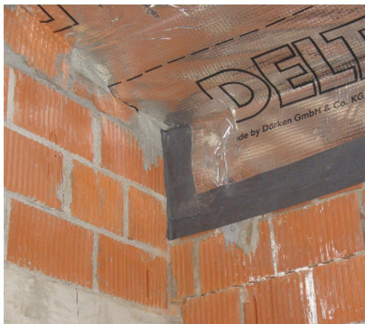
Рис. 7. Герметичная проклейка пароизоляции специальной уплотнительной лентой
