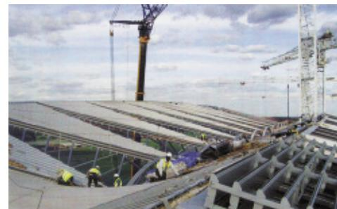
*Для монтажа были разработаны специальные шаблоны, с помощью которых предварительно подготовленные конструкции точно соединялись на строительной площадке с соблюдением жестких требований по допускам.*
