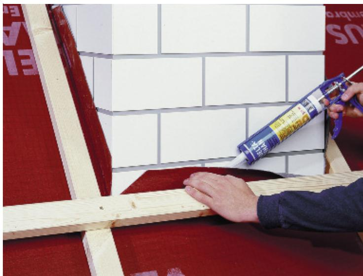
Приклейка диффузионной мембраны к печной трубе
