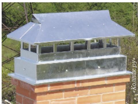
3. Дымоход с дополнительной крышей. Устанавливается для усиленного вывода холодного или горячего воздуха и в случае установки дымоходов на уровнях выше окончания трубы.
