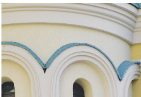
Разрезы выполнены с перехлестом, а в нижней части не сделан лоток, который бы отводил воду от стен на 70–100 мм. При таком исполнении поток воды будет размывать стены
