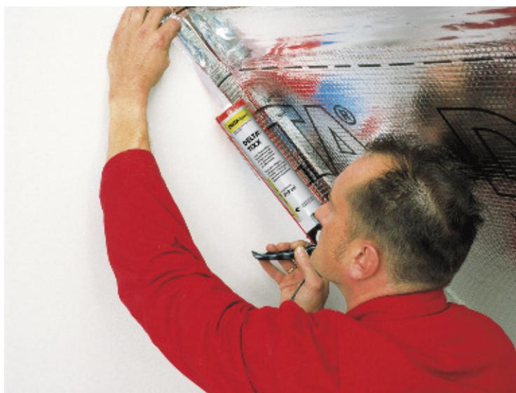
Приклейка пароизоляции к стене
