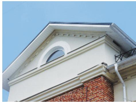
*Разрушение карниза происходит вследствие неправильно выполненной защиты. Торцевая часть должна быть отбортована хотя бы на 10 мм вверх*
